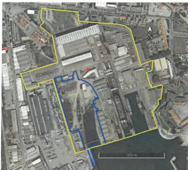
Localização da Doca Seca n.º 3 e do Aerogerador no interior do estabelecimento industrial West Sea
